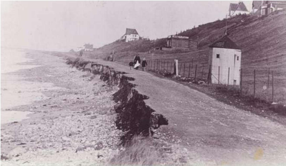
Figur 13 Stor kysterosion i Rågeleje Strandvej efter stormfloden d. 23–24 oktober 1921, og inden anlæg af høfderækken.
