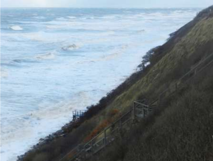
Figur 9 Under stormen, Bodil. Vandstand ca. +1,9 m. Bemærk bølgebryderne er helt overskyllede og bølgerne rammer skræntfoden (Foto: fra Hyllingebjerg, Jens Kirkegaard)
